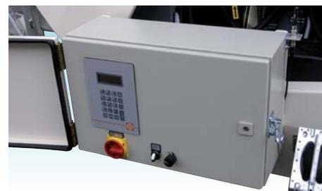
Шкаф управления подключением к силовому кабелю
